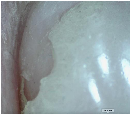
Foto: Bruchstelle bei Klarlack
